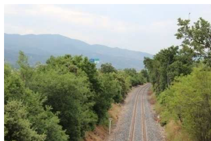
PHOTOGRAPHIE 14 : Voie ferrée - T&P 2013
